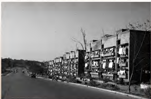
上から：小さな傘を売る男性・東京都小金井市 高島屋日本橋店・東京都中央区銀座 同潤会の青山アパート・東京都渋谷区神宮前
