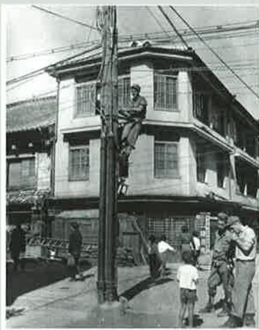
電話線の修理をする米兵 (昭和20年10月頃 長崎県佐世保) 進駐軍という、敗戦国日本を占領した印象が強いと思います。しかし、この写真のように、電線を修理し、日本の復興に協力するとともに、子供たちとのふれあいも各所で見られました。
