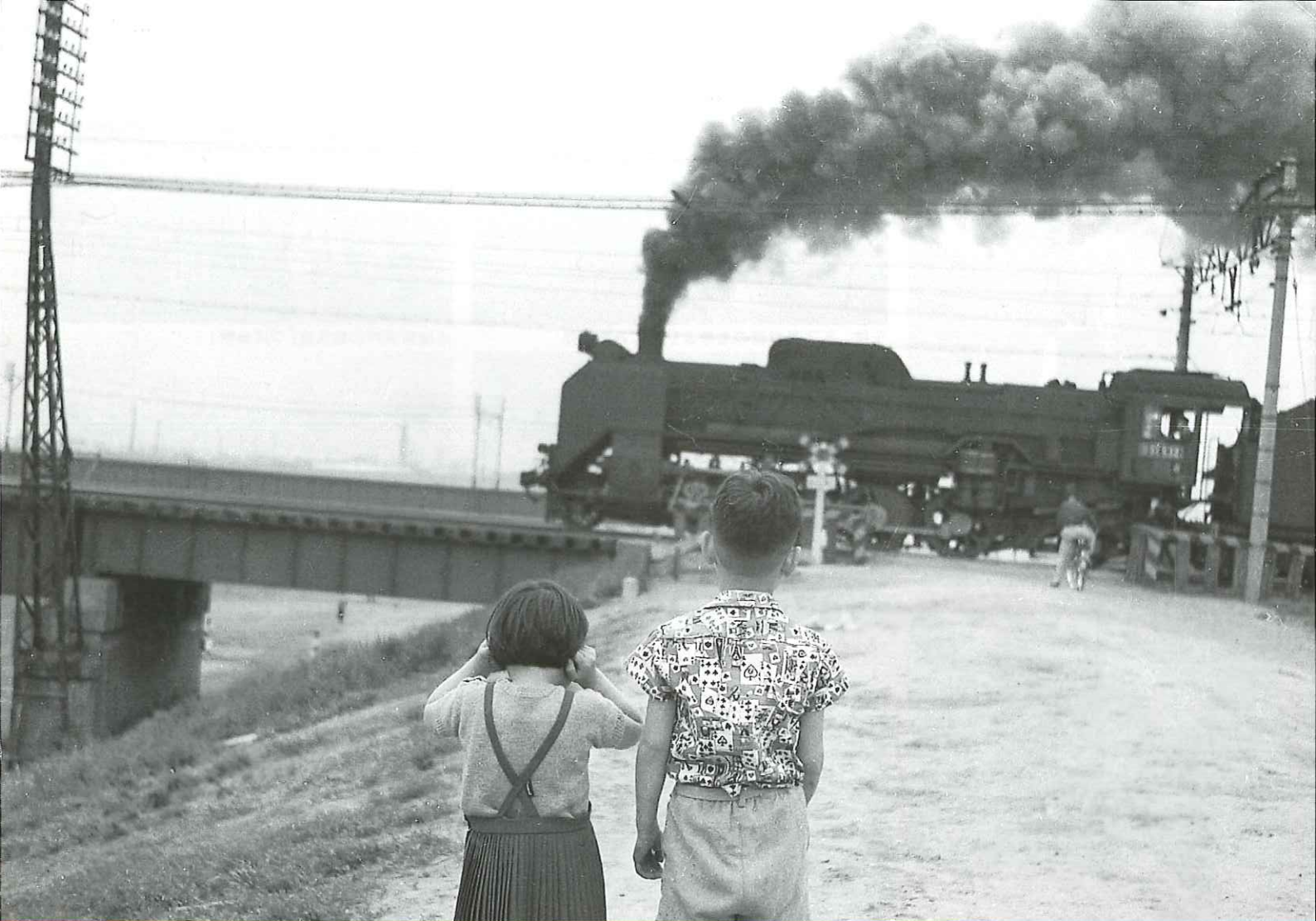
千住 荒川堤踏切を走るD51形蒸気機関車
